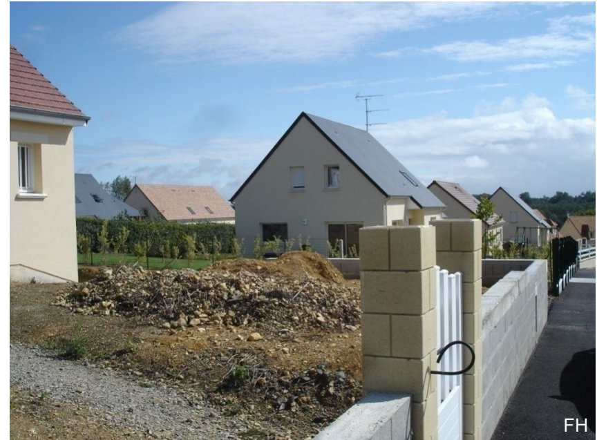
Photo : construction de deux lotissements de 60 logements à Tilly-sur-Seulles
