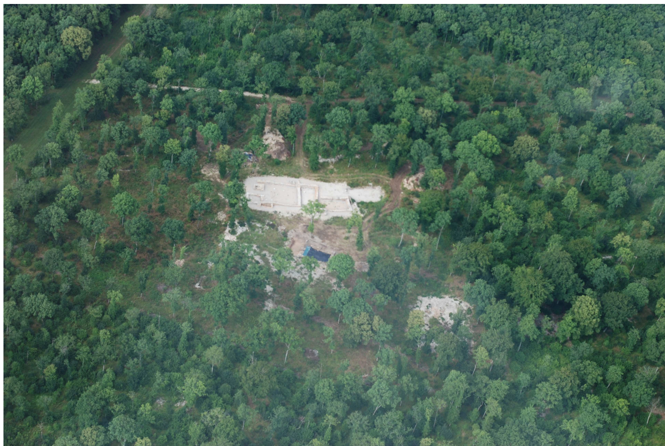
Photo 17. Vue générale du site déserté des bois de Cestres (été 2008).
