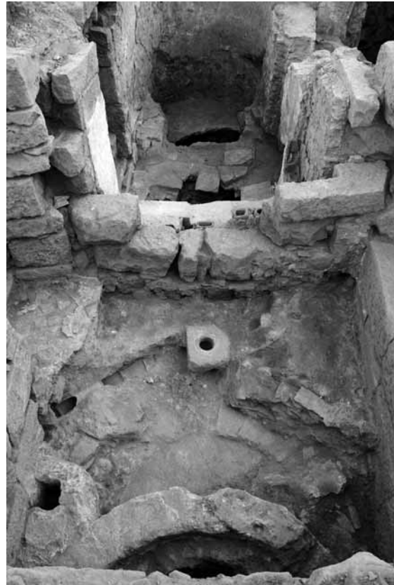
Figure 8. Les salles L.032 et L.036. Vue du nord vers le sud. Au premier plan, les deux bassins circulaires superposés © P. P-F.
