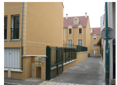
Figure 24 : Fontenay-sous-Bois, le Clos Berranger (94)
