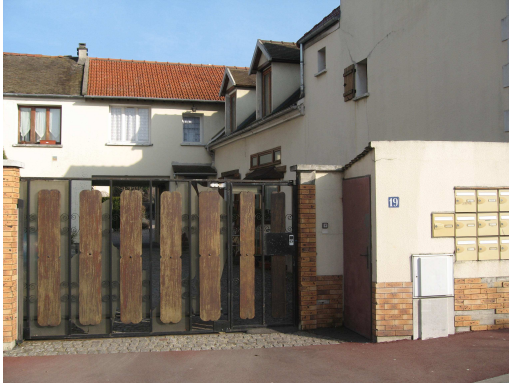
Figure 17 : Cour de ferme fermée à posteriori, dans la rue du Puis Grenêt à Soisy-sous-Montmorency, (95)
