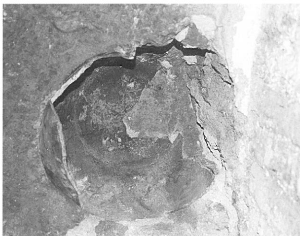
Fig. 38 : La marmite (en cours de démontage), insérée dans le mur du fond, sert vraisemblablement de niche.
