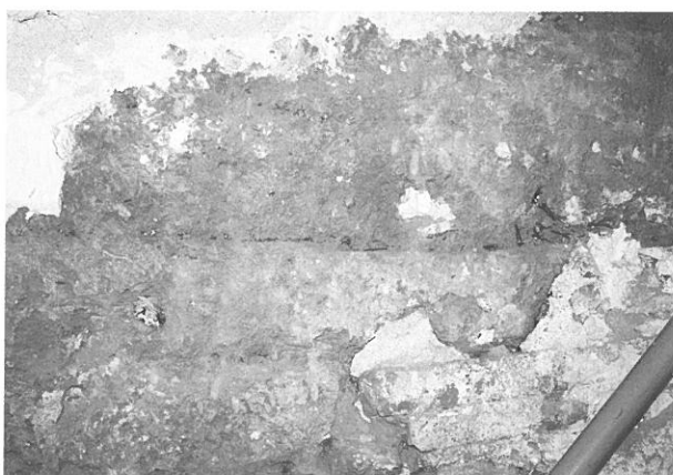
Fig. 18 : Partie du mur latéral du 5 rue de l'Hôpital, réalisé en bauge, avec des lits de bruyère.
