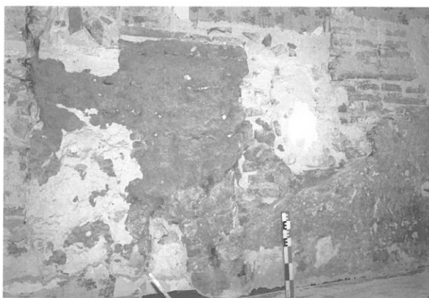
Fig. 19 : Mur latéral en bauge, au 31 rue du Four Saint-François : les lits de terre sont séparés par des végétaux auxquels sont mélangés des fragments de tuiles.
