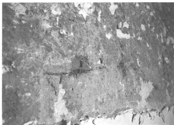
Fig. 17 : Lit de végétaux entre deux assises d'un mur de pisé au 33bis rue Arago.
