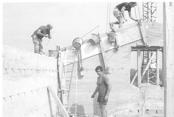
Fig. 24 : Coffrage en biais du rampant d'un pignon réalisé en béton sur un mur de pisé. Isle d'Abeau (38), îlot O. Perreau-Hamburger, 1984 (H. Guillaud, CRATerre-ENSAG)
