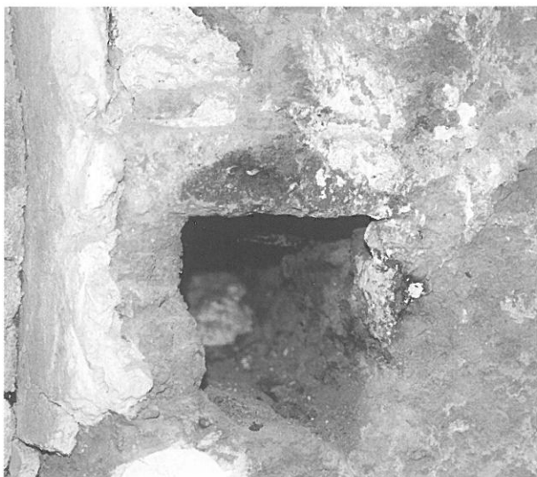
Fig. 16 : Négatif d'une grande clé de fixation de banche dans un mur de pisé. Son couvercle est fait d'une lauze.
