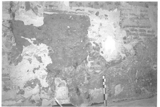
Fig. 19 : Mur latéral en bauge, au 31 rue du Four Saint-François : les lits de terre sont séparés par des végétaux auxquels sont mélangés des fragments de tuiles.
