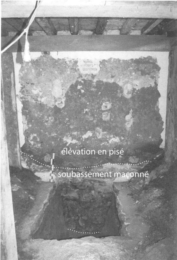
Fig. 11 : Fondation du mur de fond du 35 rue du Four Saint-François, réalisée en briques cuites. L'élévation est en pisé (P. Alessandri).
