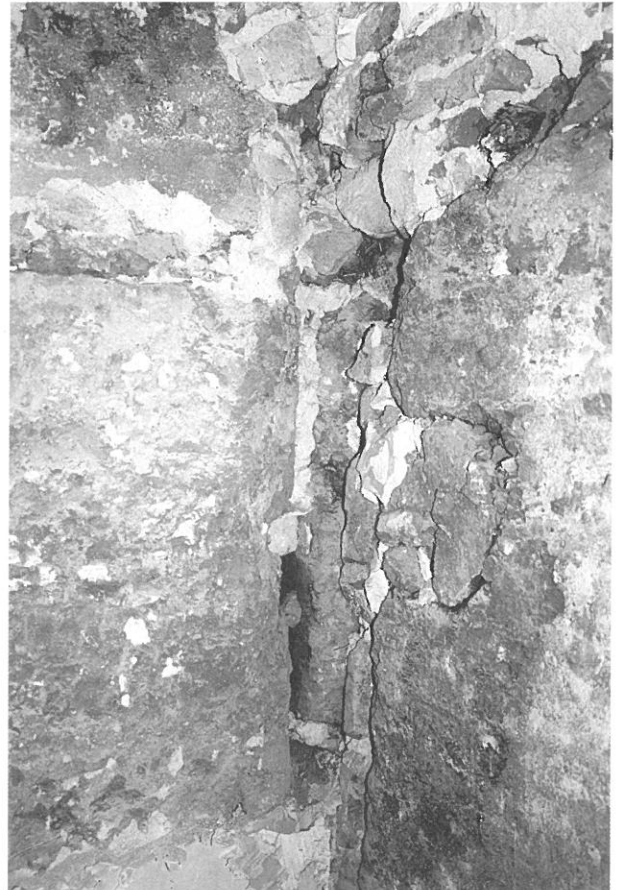
Fig. 13 : Jonction du mur médian de l'îlot avec un mur latéral, au 33 rue Arago, montrant le contact entre deux banchées perpendiculaires de pisé. Entre les deux, on distingue un angle appartenant à un mur antérieur d'une maison mitoyenne.
