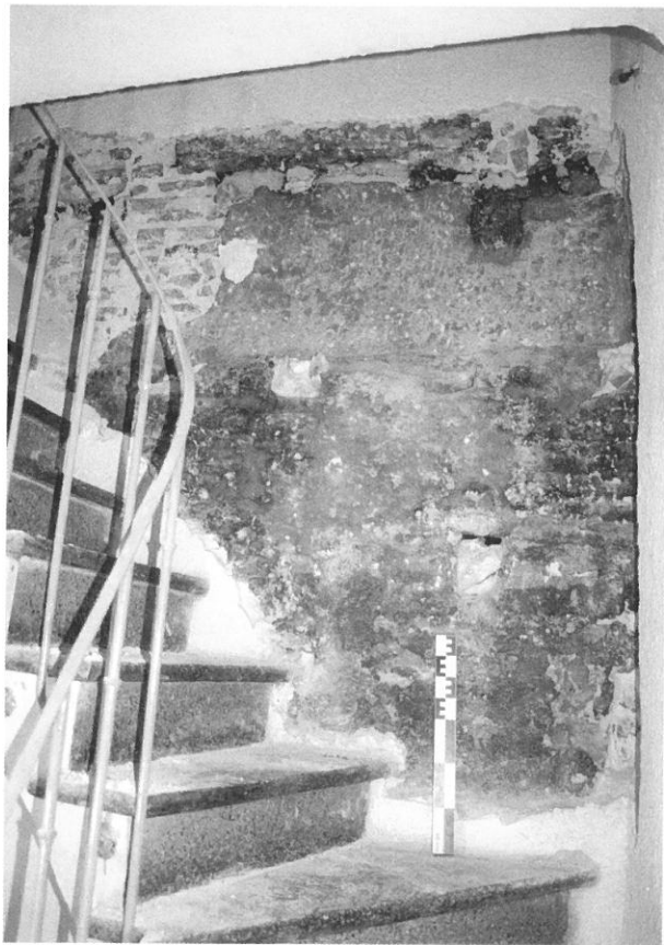
Fig. 32 : Vue de l'élévation en pisé de la maison du 15 de la rue des Commères. Les bouchons appartiennent aux trous de clé.
