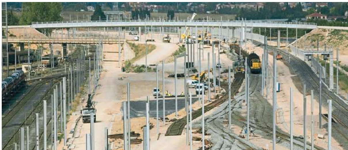
FIGURE 23: SECTION PERPIGNAN-FIGUERAS EN COURS DE TRAVAUX. SOURCE: RFF.
