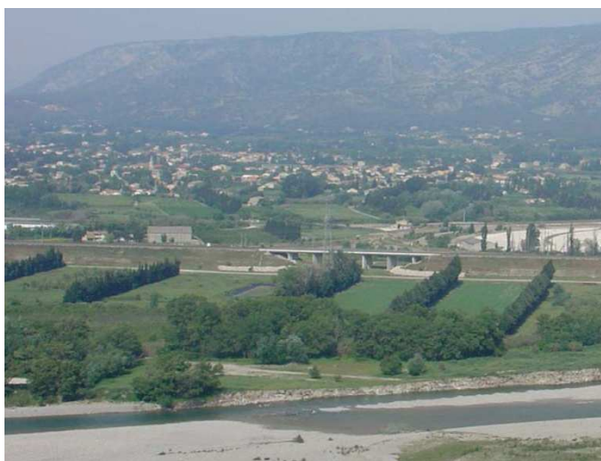
FIGURE 33: OUVRAGE DE DECHARGE DES EAUX DE CRUES SUR LA LGV MED. SOURCE: RFF.
