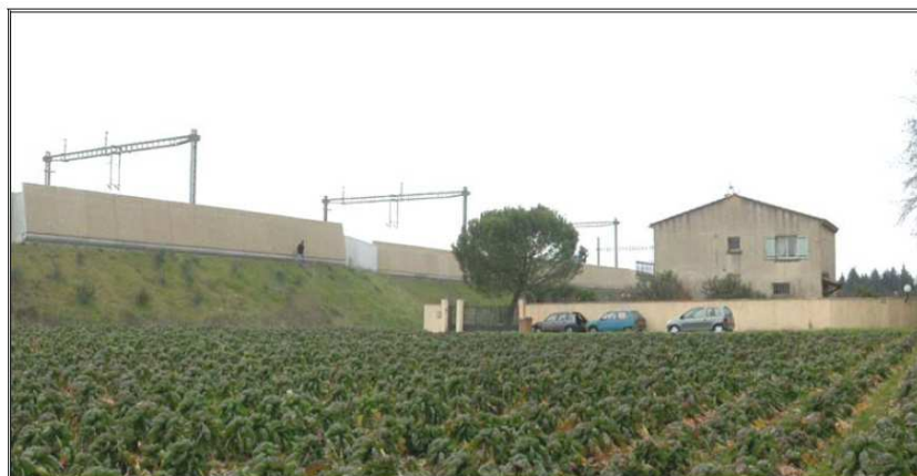
FIGURE 35: ECRANS DE PROTECTION ACOUSTIQUE SUR LA LIGNE TGV MED. SOURCE: RFF.
