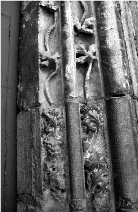
Figure 6 : Nantes, portail Saint-Pierre, ébrasement droit (détail) (cl. J.-M. Guillouët)
