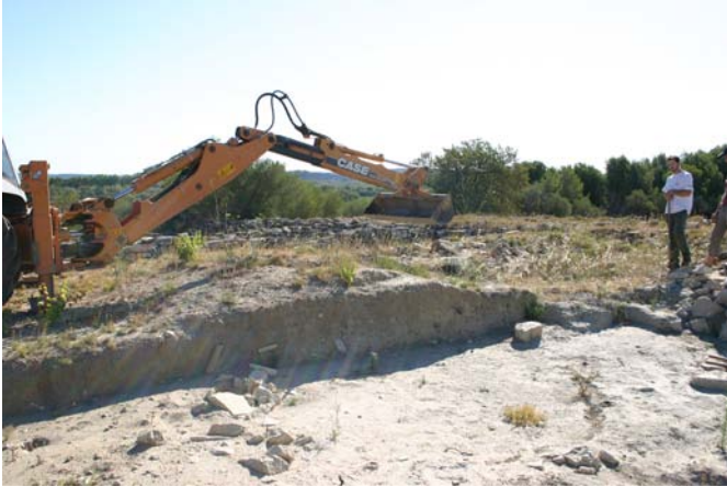
■ Fig. 06 : Décapage mécanique de la zone 77
