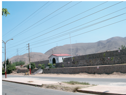
Figura 4 – Obra de protección a lo largo del río Chillón
