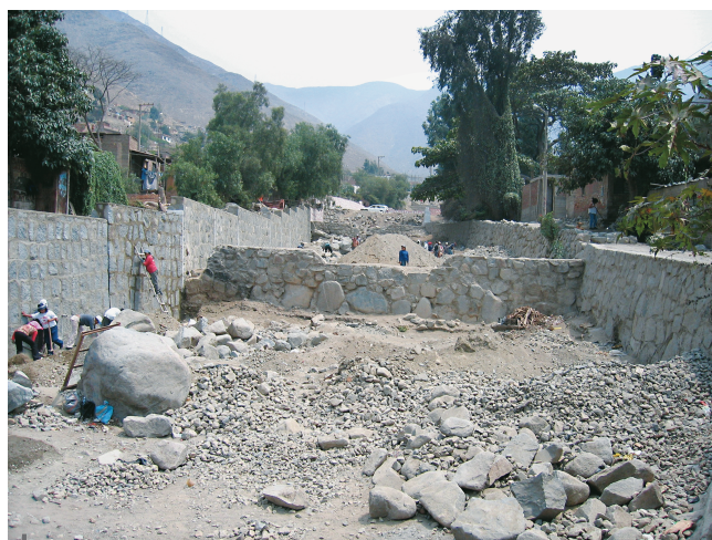
Figura 5 – Obra de acondicionamiento de la quebrada Quirio
