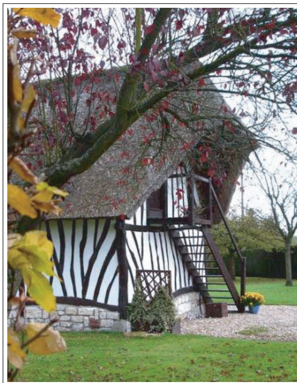
Fig. 14. Exemple de construction du XIX e siècle avec pignon avec escalier droit sous queue-de-geai, Notre-Dame de Bliquetuit, Seine-Maritime (cliché C. Gaston).
