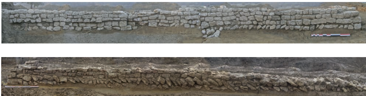
Fig. 9. Détail des maçonneries des murs extérieurs M1 et M2 de l'édifice (clichés P. Haut).
