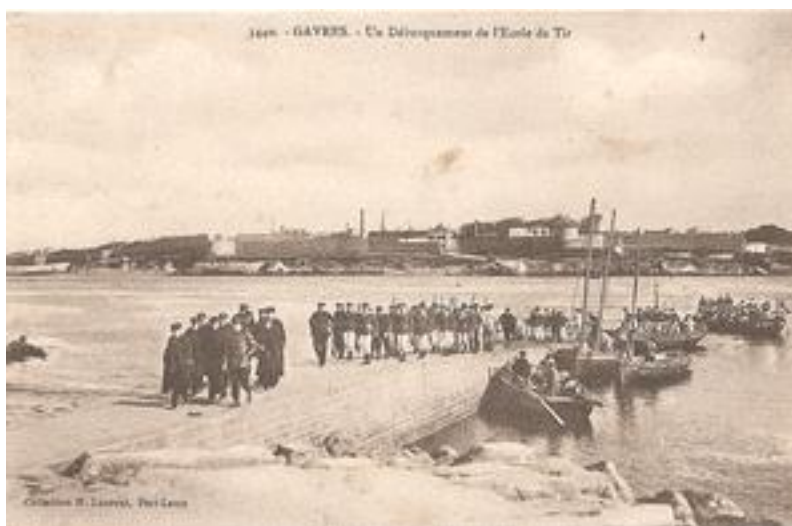
Figure 39. Une étude fut effectuée par les Ponts et Chaussées. Source : « Histoire de cales » 45 .
