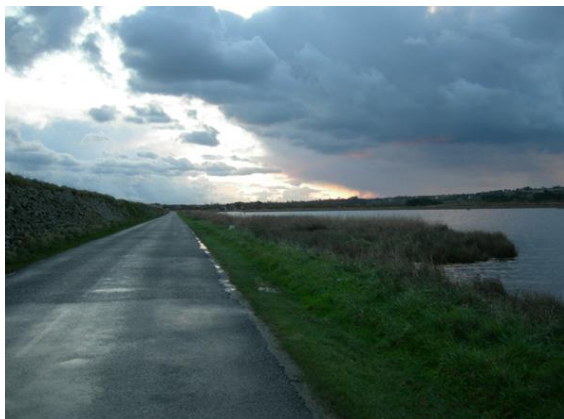
Figure 20. Sur la gauche, la digue du Curnic depuis la route de l'étang.
