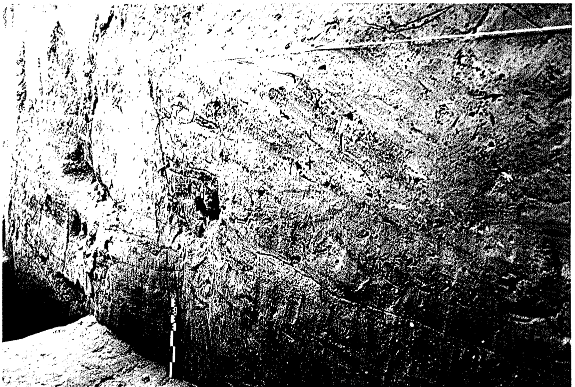
Fig. 19: Khaïtabad. Tranchée. Détail des couches gréco-bactriennes associées à la maçonnerie visible à gauche.
