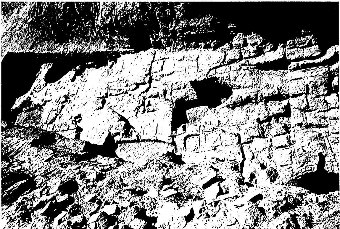
Fig. 16: Termez. chantier D. Détail des différentes maçonneries de briques crues. Vue vers l'ouest.
