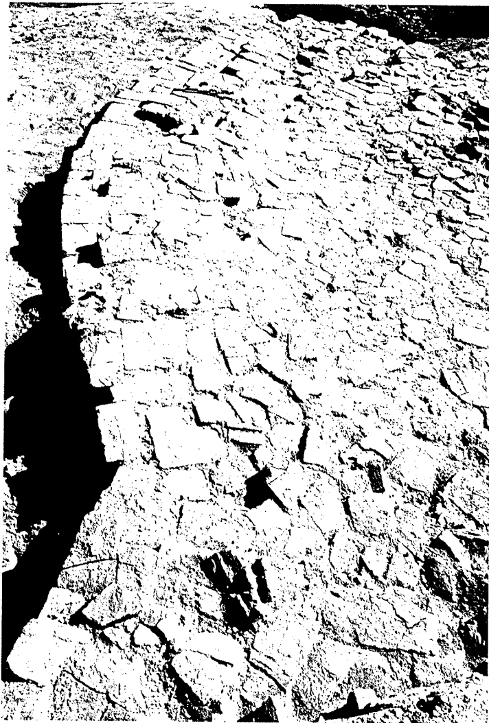
a: appareil externe du bastion en quart-de-cercle.
