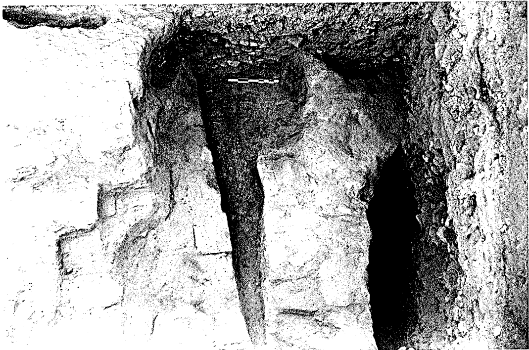
Fig. 39 : Termez, citadelle, chantier D: partie sud: à droite, mur de pierre crevé par plusieurs fosses; à gauche, mur postérieur de briques crues. Vue vers l'est.
