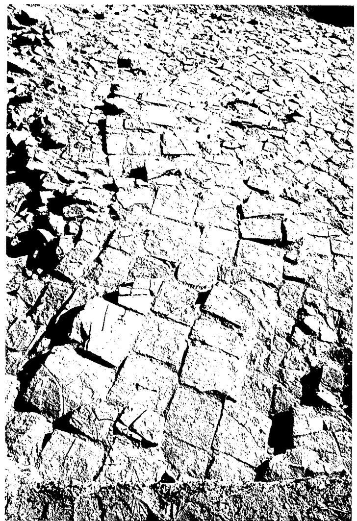
b: appareil interne du bastion.
