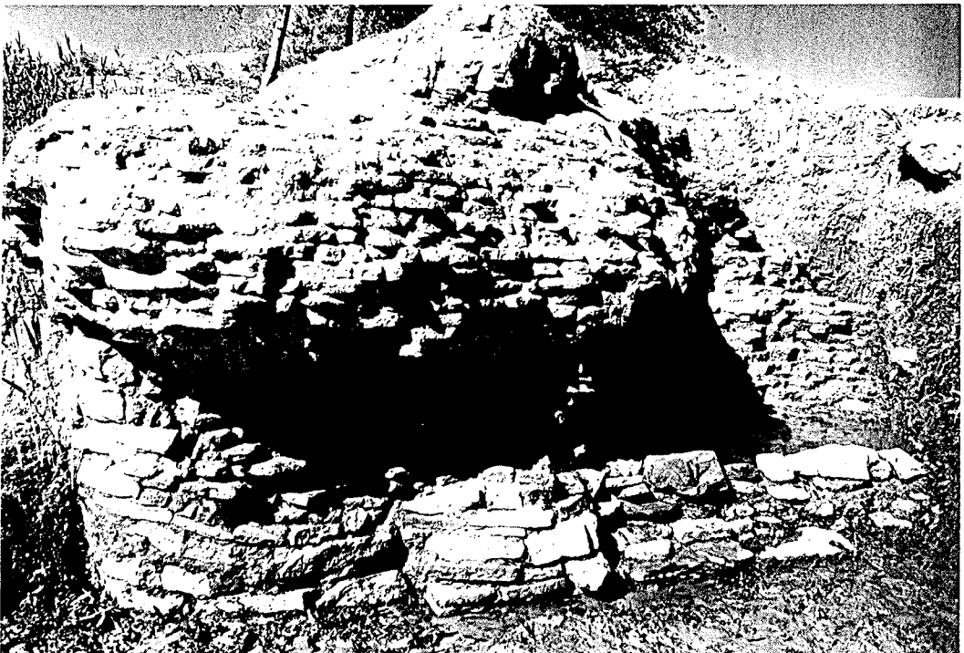
Fig. 33 : Termez, zone portuaire: vue frontale du môle ; au premier plan, mur oblique intégré dans les fondations de la tour. Vue du sud.
