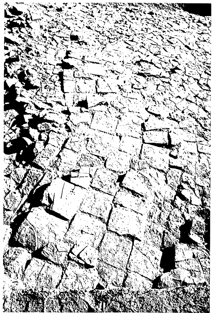
b: appareil interne du bastion.
