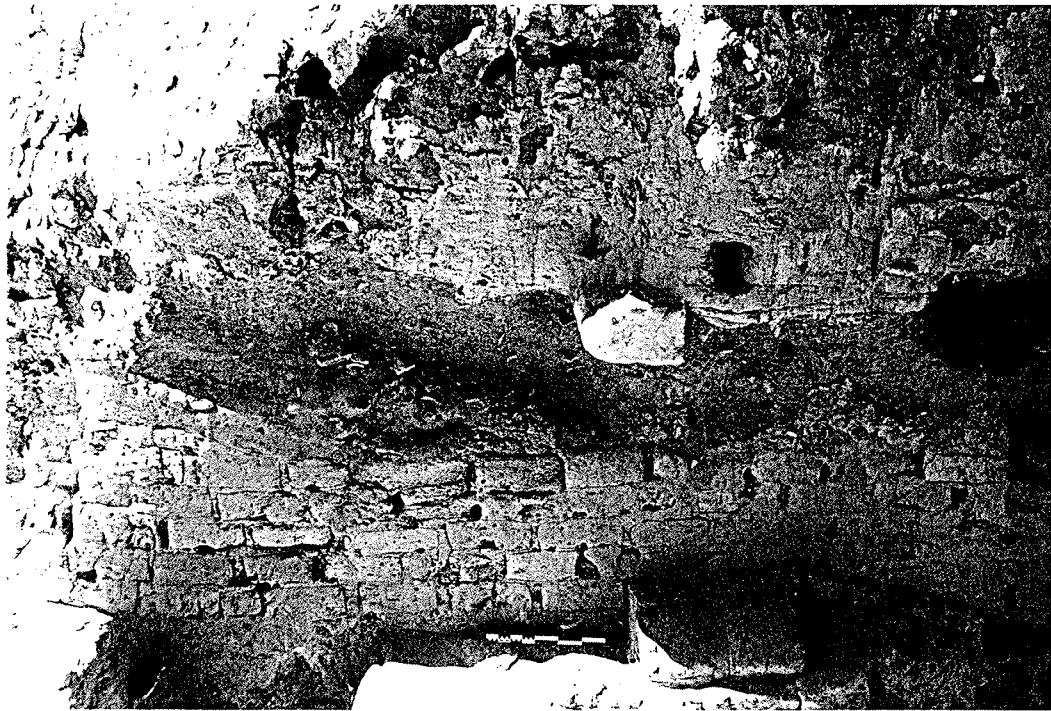
Fig. 38 : Termez, citadelle, chantier D: paroi occidentale du chantier après démontage du mur II.
