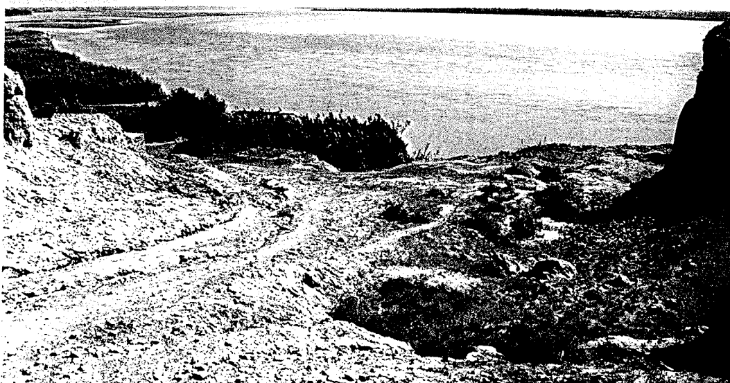
Fig. 6 : Termez, citadelle, angle sud-est: zone de destruction du rempart avant travaux et Amou Daria. Vue du nord.
