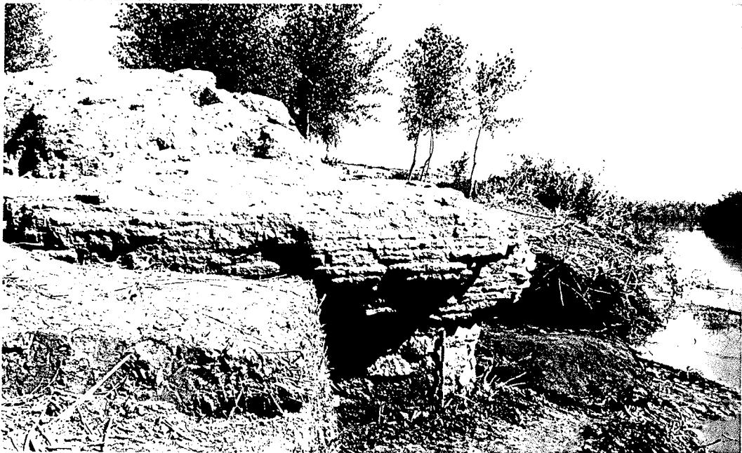
Fig. 32 : Termez, zone portuaire: vue latérale du môle avec superposition des appareils de pierre, de briques cuites et de briques crues. Vue vers l'est.
