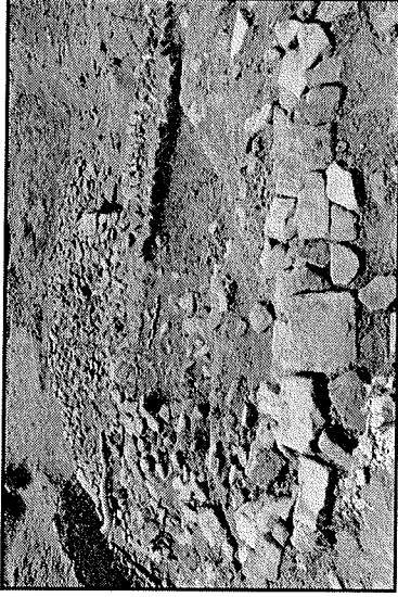
Fig. 33: Citadelle de Termez. Tranchée B: sommet des murs M34 à gauche, M35 à droite, et de la tour M3 au fond. Vue vers le sud.
