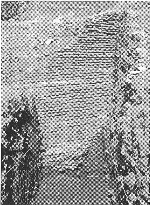
1 - Angle sud-est. Sondage au pied de la muraille N. On distingue nettement deux états de construction séparés par un ressaut et, à la base, les vestiges d'une maçonnerie antérieure englobée dans les fondations de l'état le plus ancien. Vue vers le nord.
