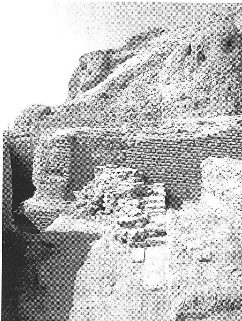
Fig 8 : Citadelle. Chantier angle sud-est. Vue de la face orientale du massif 4. On distingue nettement la réfection de sa partie avant et le contact avec les maçonneries du nouveau mur(23) et du mur (15a)
