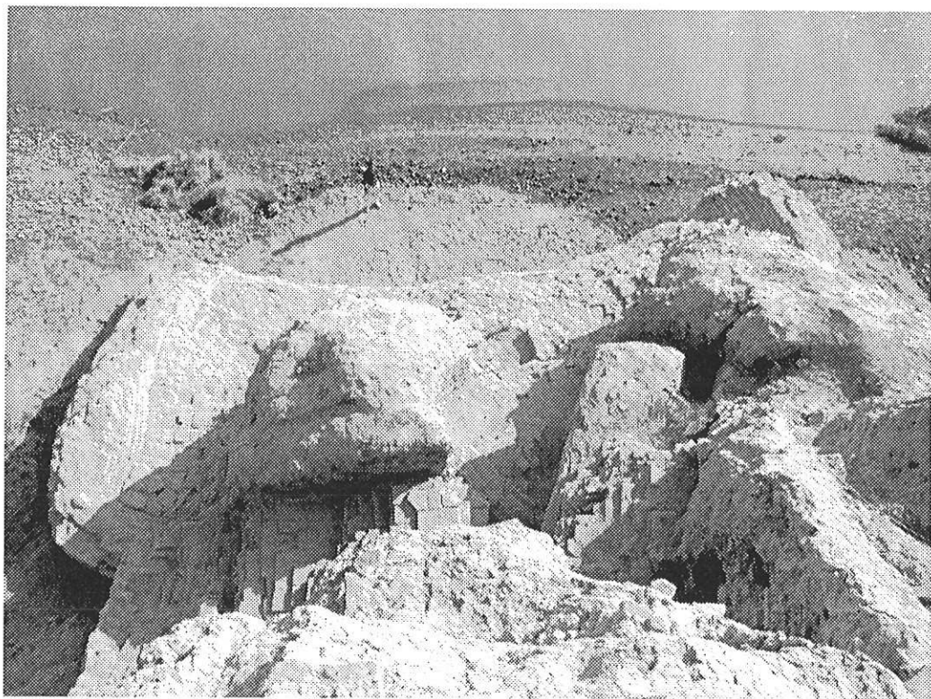
Fig 14 : Citadelle. Chantier angle sud-est. Vue du bastion 10 depuis le sommet de la partie conservée des remparts. On distingue nettement la zone extérieure ouest et est maçonnée au mortier de chaux et mieux préservée que la zone centrale maçonnée à l'argile. Au premier plan, le local circulaire intérieur de la tour, en partie occupé par un rocher allongé. (La zone semi circulaire à l'avant du bastion est constituée de remblais récents et n'a aucune signification pour l'interprétation de la forme de la partie disparue).
