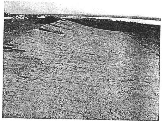
Fig 37 : Tchingiz Tepe I. Courtine T4-T5 et tour 5. Massif de briques crues Vue depuis le Nord
