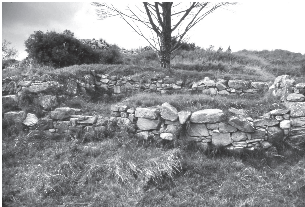
Fig. 19. Vue depuis l'est de l'intérieur de la porte à cour du Cayla de Mailhac avec le "podium" bordant l'espace de circulation (© E. Gailledrat).
