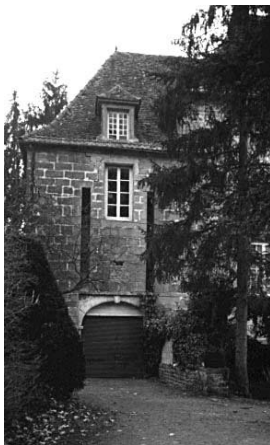
Fig. 3 : tour porche de la maison forte de Meilly-sur-Rouvres (Côte-d'Or), cl. H.M.
