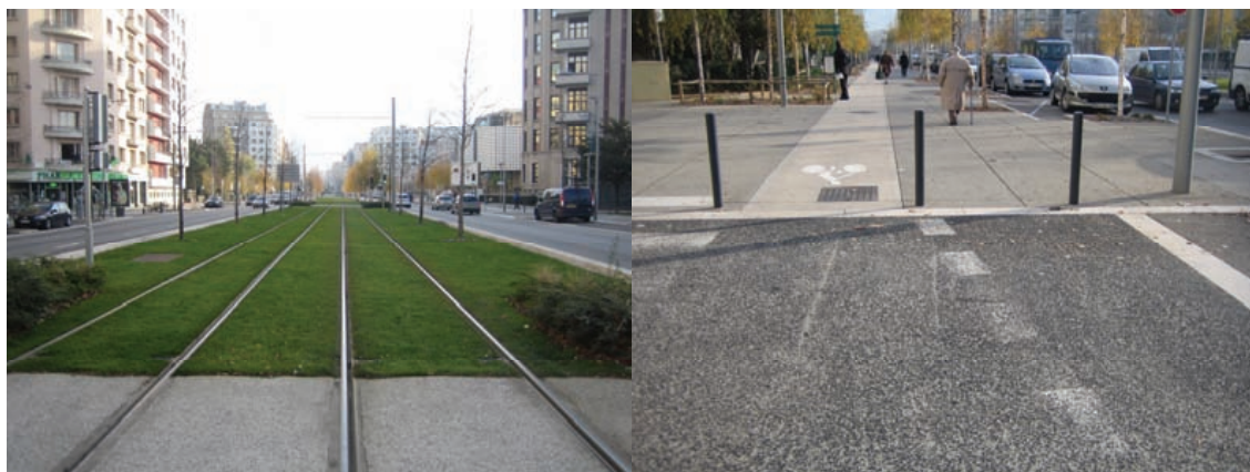
Étanchéification et canalisation des flux (photos RT)
