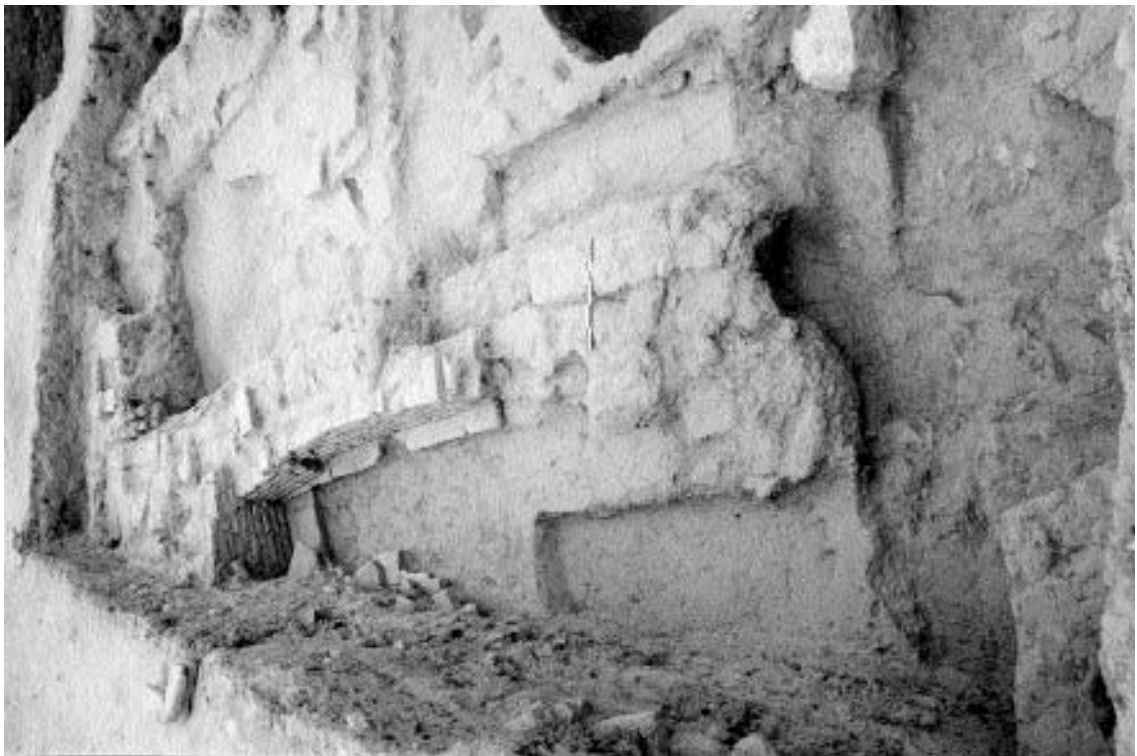
Fig. 25 Ancienne Termez. Chantier “Ville”, phase I, partie sud du chantier; vue de la troisième pièce dont les murs ont été reparamentés de briques cuites; en haut à droite, la pièce sud (vue vers le sud-ouest).
