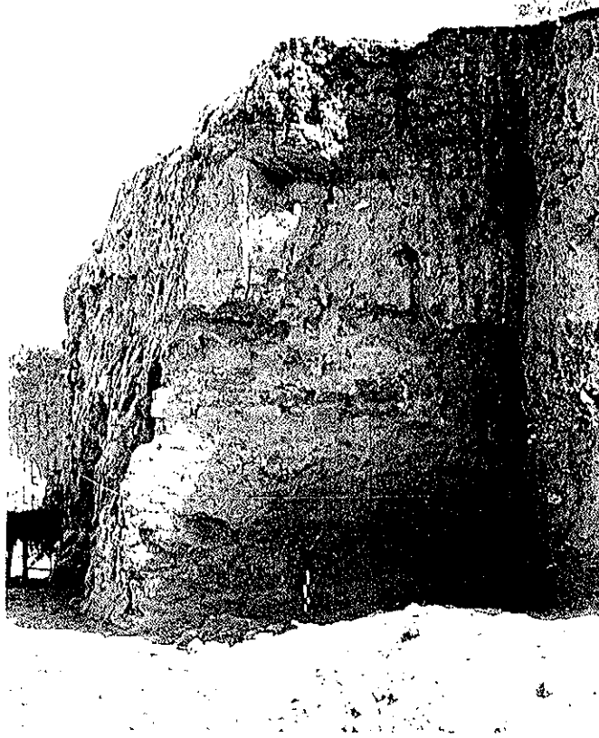
Fig. 23: Karabag Tepe. Face de la muraille ouest après nettoyage. Noter la présence de l'archère à droite. Vue de l'ouest.
