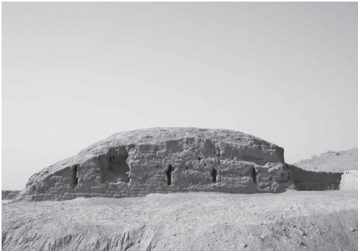
Fig. 29 Tchingiz Tepe 1: Façade occidentale de la tour 5 avec cinq archères. Vue vers l'ouest.
