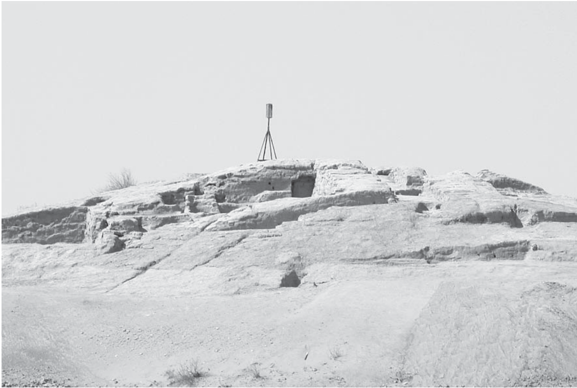
Fig. 8 Tchingiz Tepe. Vue de la tour 1 depuis l'extérieur, vers l'ouest.
