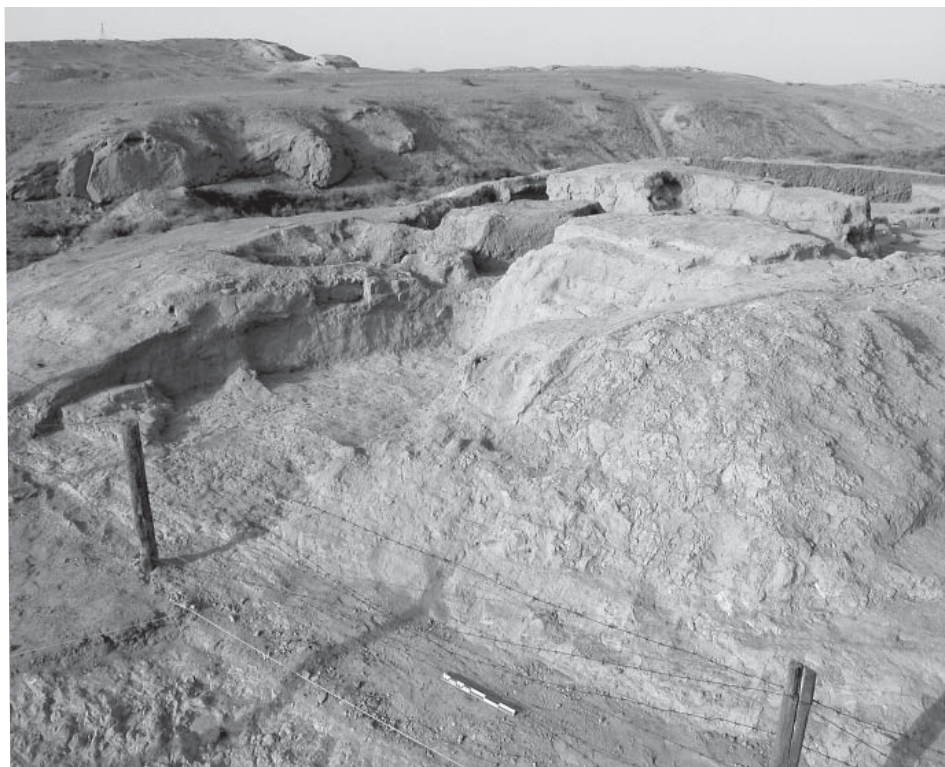
Fig. 46 Complexe culturel. Edifice B. Vue générale vers le nord-ouest. Le bâtiment a été gravement affecté par les tranchées.
