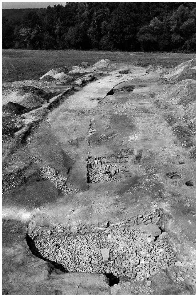
Fig. 31 – Vue du nord-est du mur d'enceinte de Mandeuve avec la tour 1 en premier plan ; on note quelques grands blocs posés à plat sur le hérisson de pierres (cliché : G. Kuhnle, INRAP).
