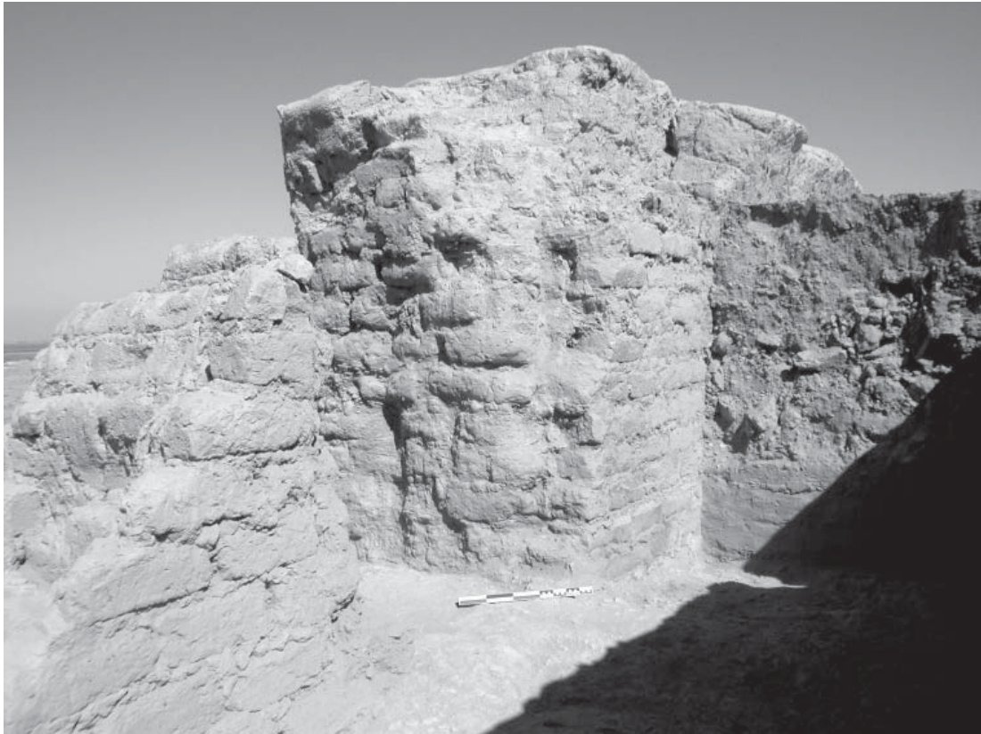
Fig. 18 Tchingiz Tepe. Rempart Nord : ouverture de l'accès à la tour 13 à partir du couloir de la courtine C12-13. On notera la présence d'un départ de voûte.
