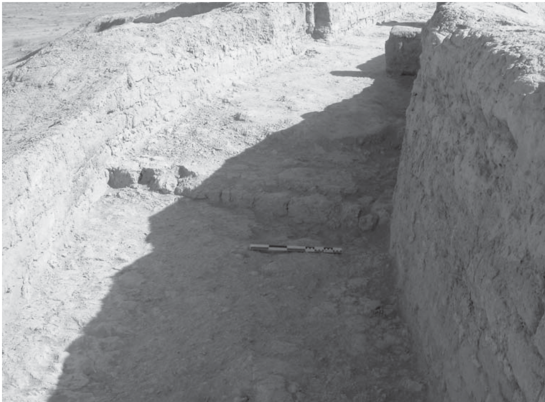
Fig. 15 Tchingiz Tepe. Rempart Nord : la courtine C10-11 forme un coude. Noter la présence d'une marche. Vue vers l'est
