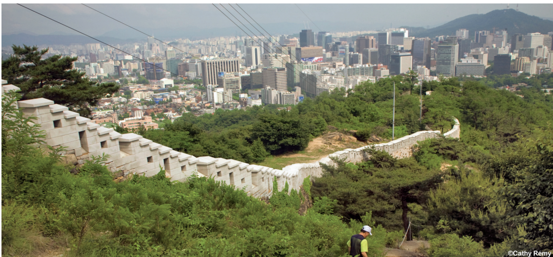
Depuis le mont Inwang, vue sur le quartier d'affaires du centre historique par delà une section rénovée des murailles.
