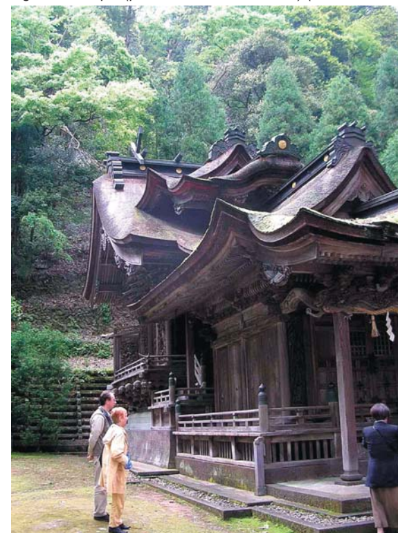
Figure 3. Temple (préfecture de Fukui, 2005) (© Yvon Le Caro)
