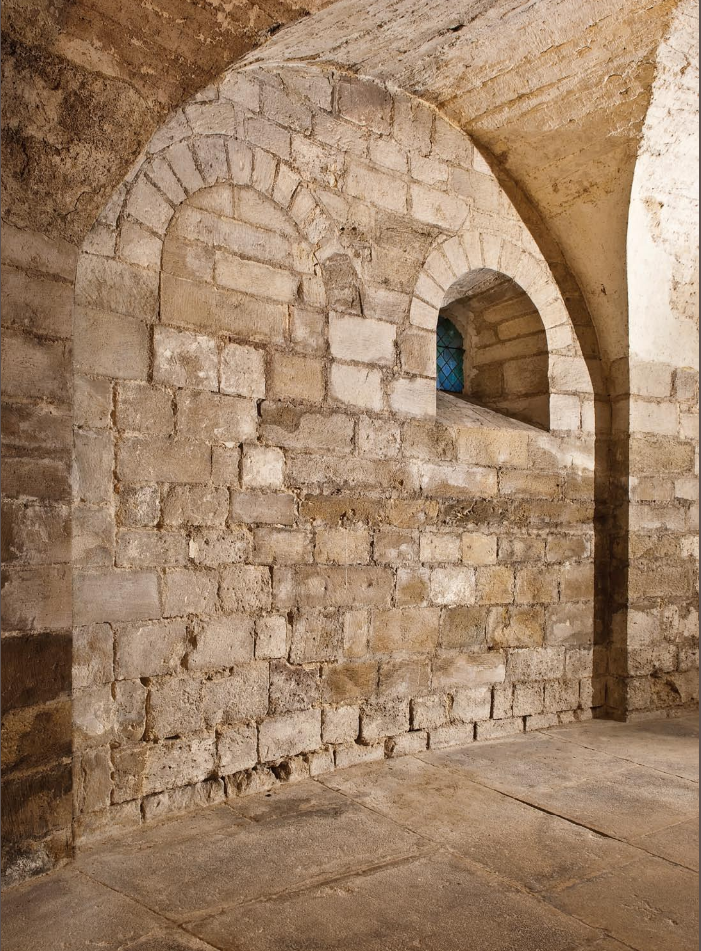
Fig. 11 Vue des accès bouchés et restaurés menant de la crypte au palais épiscopal (cl. G. Puech).
