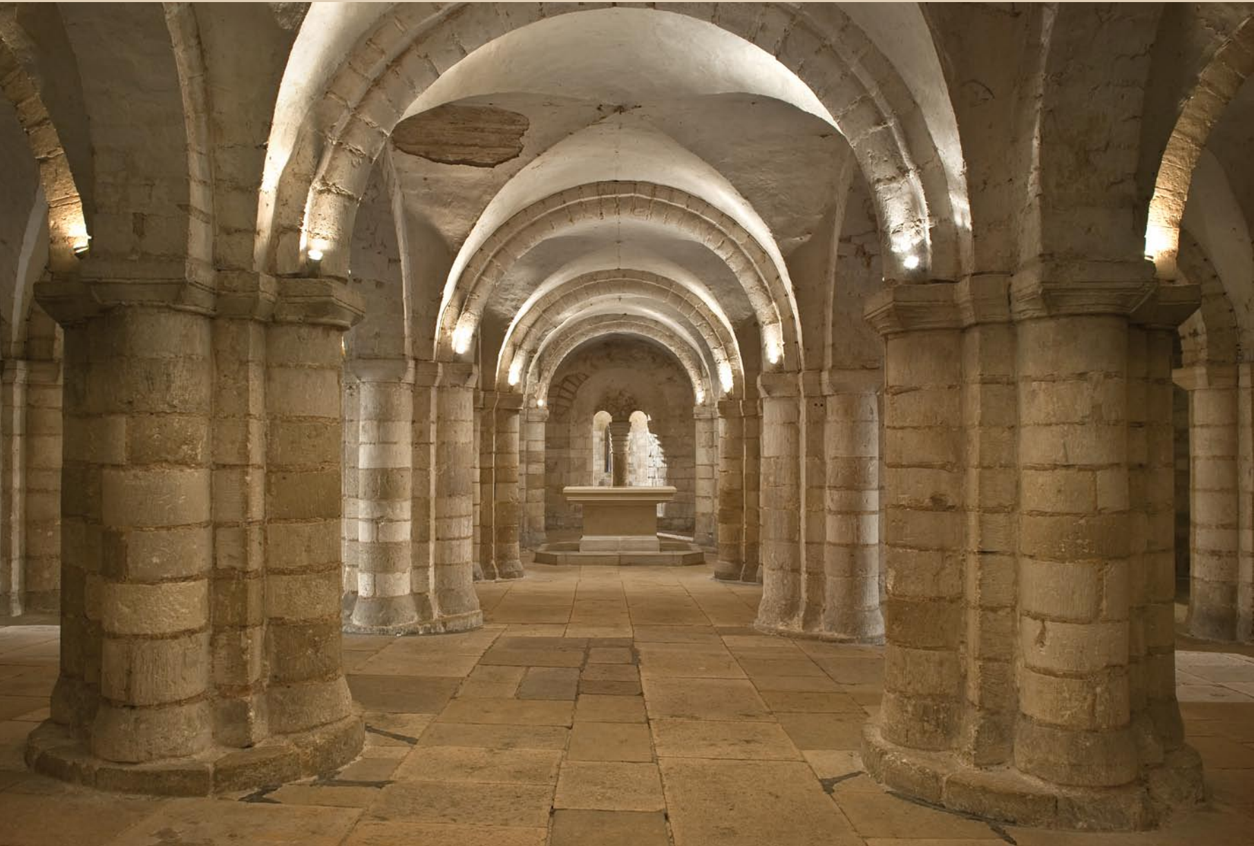
Fig. 1 Vue générale de l'intérieur de la crypte (cl. G. Puech).
