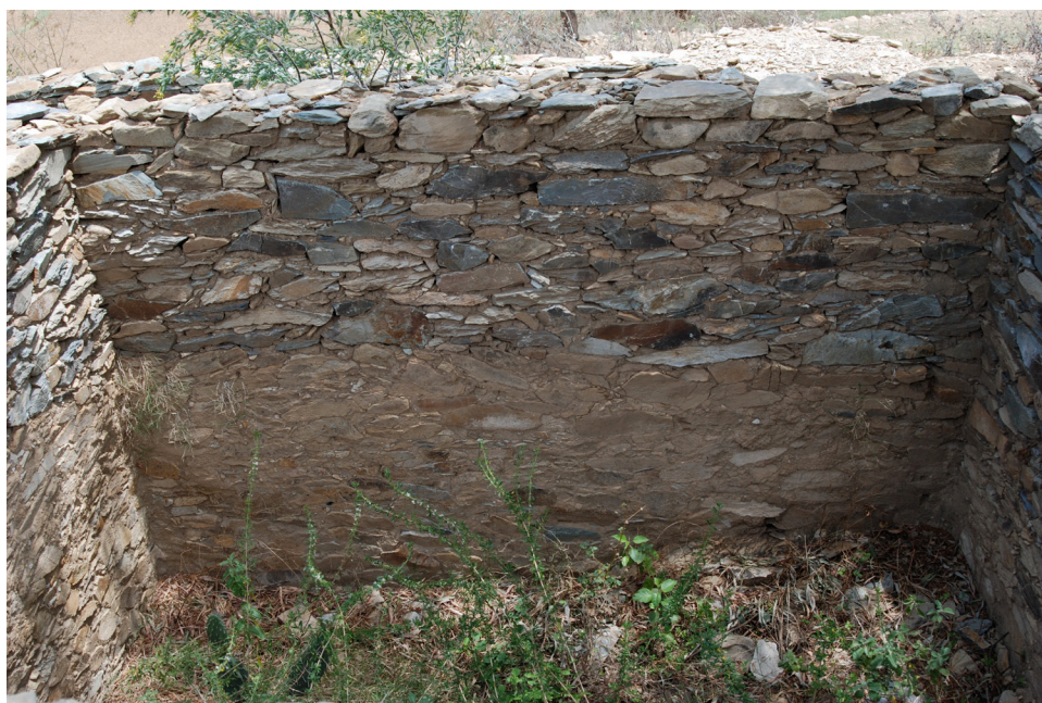
Phot. 26 – Wakarida, limite visible du rehaussement récent sur les structures dégagées par la population locale en D2 (phot. F. Dugast 2011)
