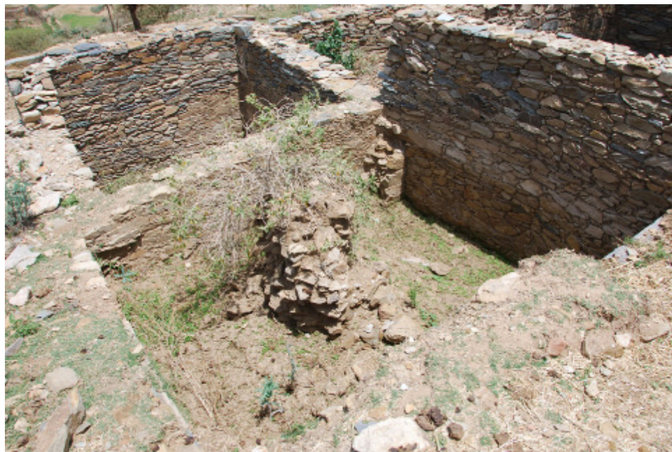
Phot. 1 – Wakarida, premières structures antiques visibles, dégagées par la population locale en quête de pierres (phot. F. Dugast 2010)
