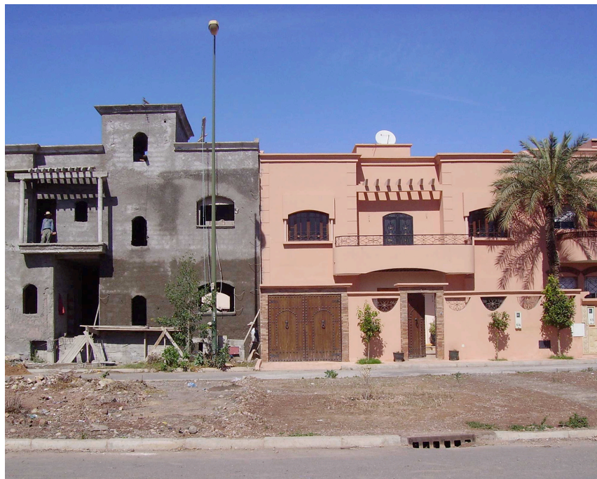
Photos 1 et 2. El Izdihar à l'ouest de Marrakech : palmeraie mitée par les nouvelles villas. Clichés : Elsa Coslado, 2007.
