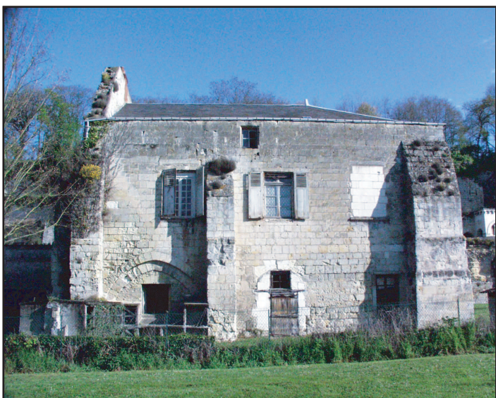
Vue de la façade sud
