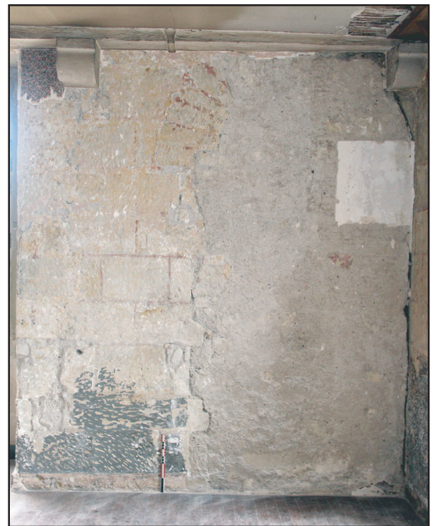
Détail d'une ancienne ouverture située au second niveau dans l'angle sud/ouest
