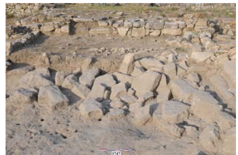
■ Fig. 18 : Vue de l'effondrement 77237, depuis l'est.
