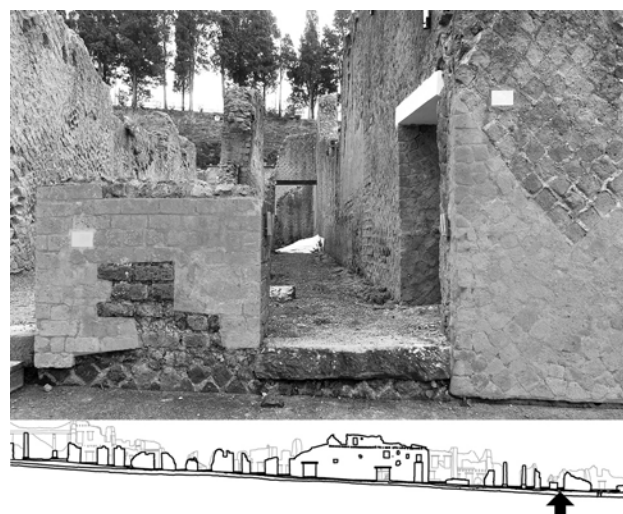
Fig. 128 – Façade de l'entrée Or. II, 2. Les restaurations modernes sont soulignées en grisé. L' opus reticulatum B qui constitue le montant droit a été taillé après la construction initiale pour percer cette porte.
