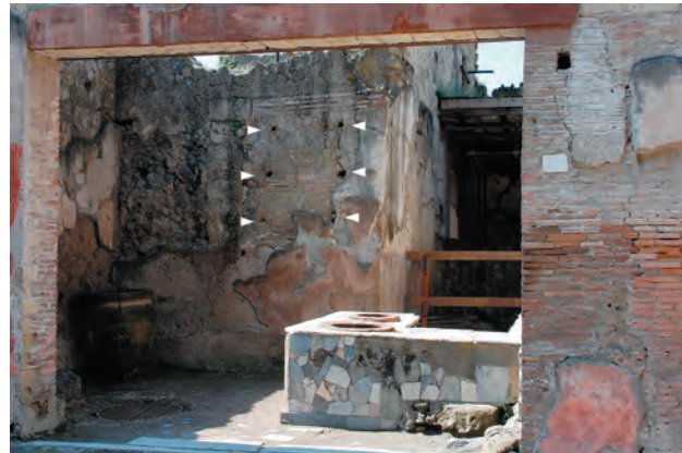
Fig. 54 – Commerce alimentaire (V, 9-10) en façade de la Casa dell'Apollo citaredo . Sur le mur du fond, six encastresments (soulignés par des flèches) devaient servir de support soit à une étagère, soit à un porte-amphores (cliché pris du nord-ouest).
