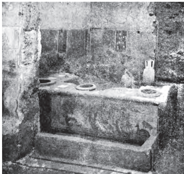
Fig. 33 – Comptoir de la boutique «de Pherusa» (III 6, 1). Le bombardement de 1943 a détruit l'ensemble (comptoir, fresque et aménagement en terre crue).
