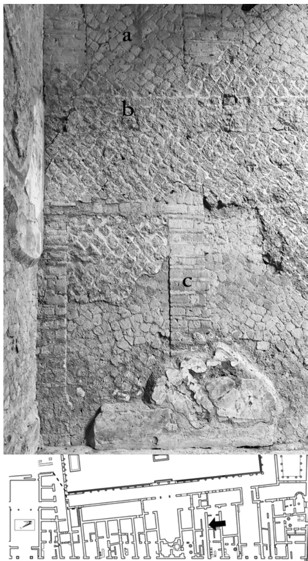
Fig. 126 – Insula Orientalis II a , pièce A, mur nord. Même paroi que dans la figure précédente, vue de l'autre côté. On notera que sous la fenêtre (a), aucune solive ne soutient le plancher en (b). En bas, le montant oriental de la porte (c) est recouvert d'un enduit correspondant à la décoration initiale, indice de révision du projet initial.
