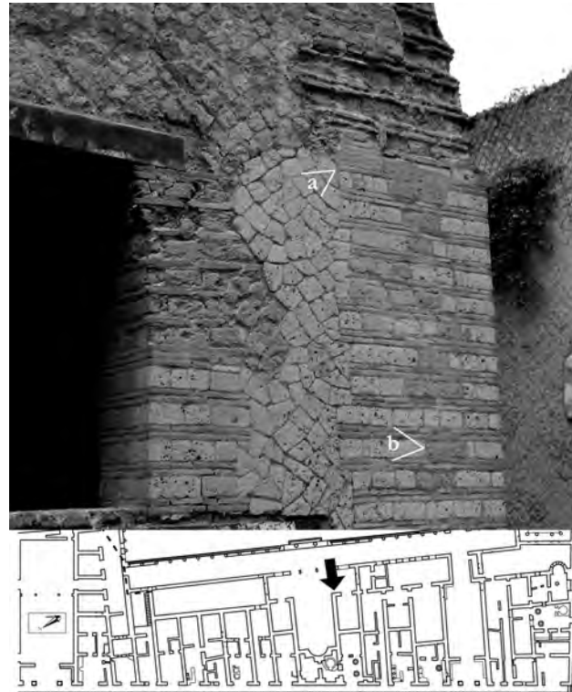
Fig. 114 – Montant nord est de la pièce II dans la « Palestre ». La différence de couleur du tuf souligne les parties restaurées des parties antiques: (a), rangs de briques pouvant indiquer une première réparation avant celle effectuée en opus vittatum mixtum ; (b), moellons de maçonnerie antique incorporés dans la reconstruction moderne.
