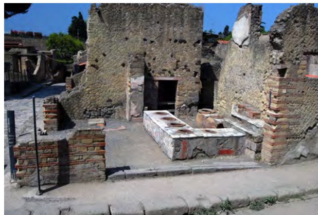
Fig. 161 – Grande taberna con abitazione (IV, 12-13.15-16), boutique IV, 15-16. Après le second séisme, un pilier a été ajouté au sud pour maintenir le mur de refend avec la pièce 8/9, tandis que les montants des entrées ont été restaurés. Ces travaux ont été effectués en opus vittatum mixtum à deux assises de briques (cliché pris du nord).
