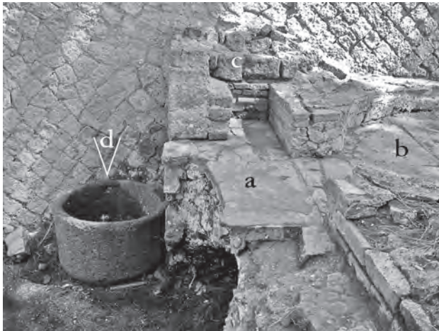
Fig. 75 – Four de la boulangerie Or. II, 1a à Herculanium. Bien que fortement dégradées, les principales composantes de cet aménagement ont été conservées. L'autel (a) est revêtu de tuiles plates, comme la sole (b). Les vestiges du mur-diaphragme permettent d'envisager la présence d'un chauffe-eau (c), pourtant indiqué dans les journaux de fouilles de l'autre côté de la gueule. Devant le four, un bloc de roche volcanique a été taillé en cylindre (d), peut-être pour recueillir les braises entre deux fournées (cliché pris de l'ouest).
