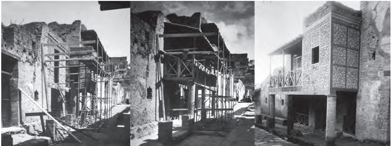
Fig. 12 – Les différentes étapes de la reconstruction de la Casa a graticcio en 1929.
