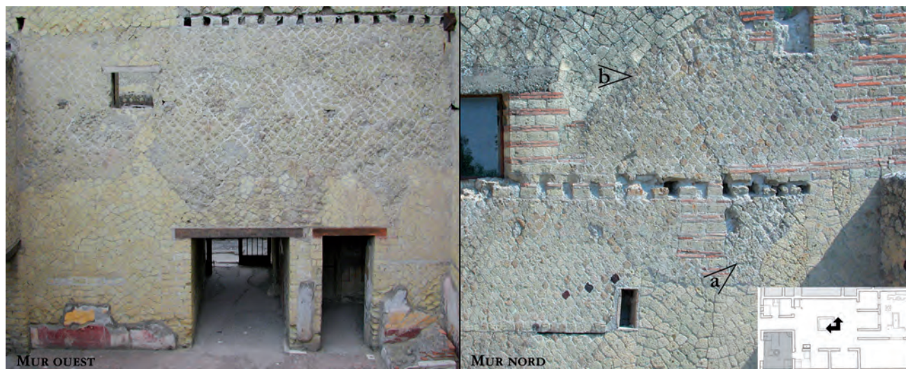
Fig. 182 – Casa di Nettuno e Anfirite (V, 6-7), atrium, murs ouest et nord. La maçonnerie du mur ouest, remontant à la construction de la maison, est intégralement réalisée en opus reticulatum B. Le mur nord montre, outre les lambeaux de la maçonnerie originelle (a), d'importantes réparations effectuées après le second séisme (b), en employant l' opus reticulatum A et l' opus vittatum mixtum à deux assises.
