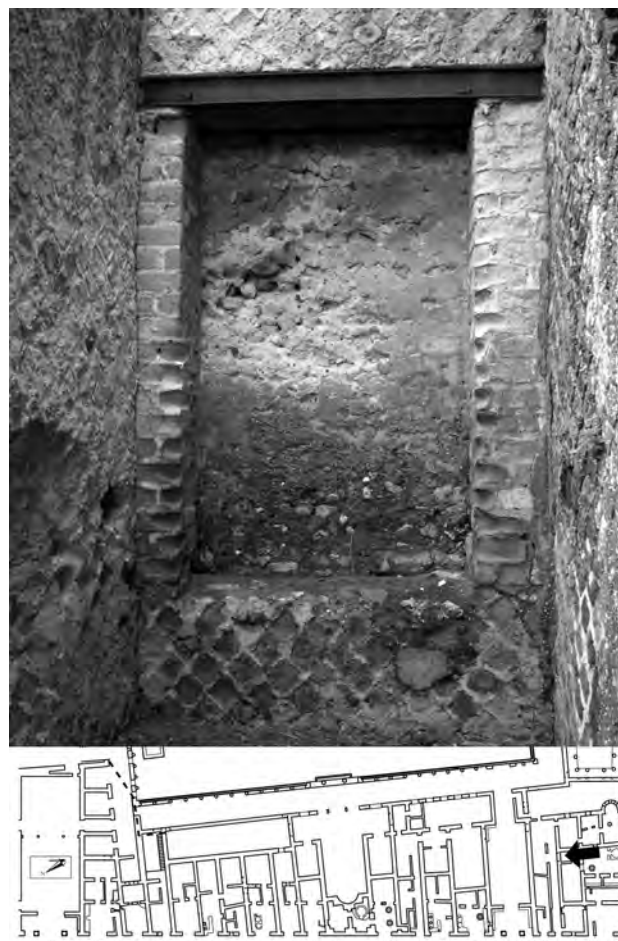
Fig. 129 – Porte bouchée dans la paroi nord de la pièce 1a-4 de l'Insula Orientalis II a . Ouverte lors du projet initial, cette porte permettait le passage entre les pièces 1a-11 et 1a-4 grâce à une volée de trois marches.
