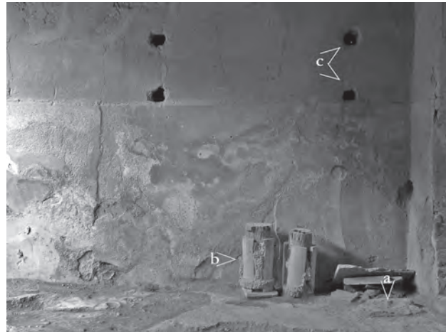
Fig. 107 – Fullonica « de Stephanus », entrée, mur oriental, traces de la presse à vêtements. (a) : empreinte en plâtre du montant méridional. (b) : lanternes en fer restaurées sur des billots de bois moderne ; (c) : empreinte des poutrelles de maintien du banc (cliché pris de l'ouest).
