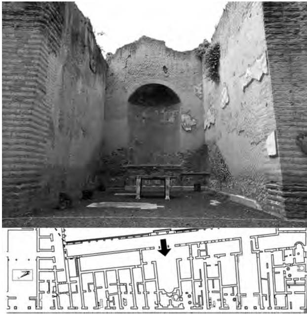
Fig. 113 – Aula absidata dans la « Palestre ». L'abside et le mur du fond sont construits en opus reticulatum B et en opus vittatum . À gauche et à droite, les montants des salles II et III ont été restaurés dans une phase successive en opus vittatum mixtum à deux rangs de briques.
