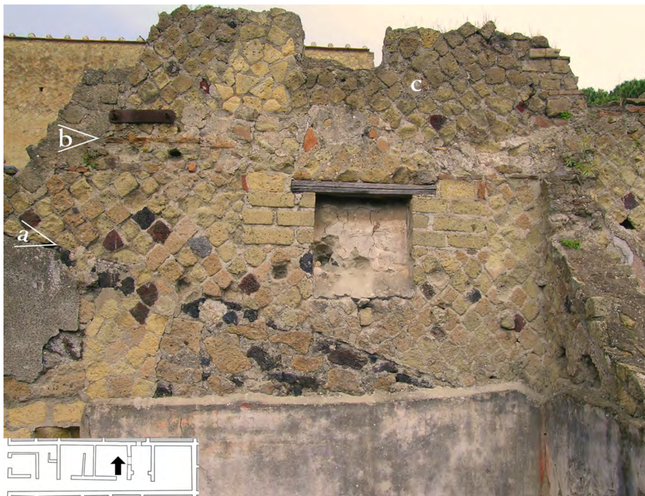
Fig. 153 – Casa del papiro dipinto (IV, 8-9), pièce 4, mur nord. Cette portion de mur permet de suivre les différentes transformations survenues dans cette maison et dans celle située immédiatement au nord, la Bottega con abitazione (IV, 10-11). Une limite oblique (a) correspond à la mise en place d'une toiture asymétrique à double pente dans les deux domus, au début du I er siècle avant notre ère. Durant la période augustéenne, la Casa del papiro dipinto accroît le volume de ses pièces avec une toiture plus élevée (b) supportée par de l' opus reticulatum B, sans créer un véritable étage. Ce dernier n'est mis en place que lors d'une extension en hauteur réalisée en opus incertum C / opus reticulatum grossier de tuf jaune (c) par les occupants de la Bottega con abitazione qui dotent alors leur maison d'une sous-pente après le séisme de 62.
