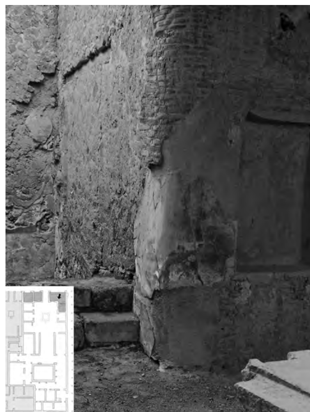
Fig. 190 – Atelier VI, 12, angle rentrant au sud-ouest. La forme arrondie employée pour cette réparation pourrait être un essai pour limiter l'effet des coups de bélier entre les murs en cas de séisme.
