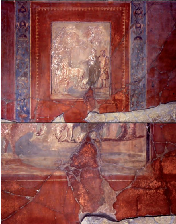
Fig. 1 – Casa del bicentenario , tablinum, mur ouest, vue générale et détail. Le cadre représentant Dédale et Pasiphaé présente une fissure en biais. Une partie de celle-ci a été restaurée par l'insertion d'un fragment d'enduit dont la couleur est sensiblement différente du reste de la fresque.
