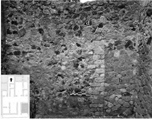
Fig. 169 – Casa del gran portale (V, 35), pièce 9, mur nord. Ce mur a été restauré en utilisant des moellons de remploi après le séisme de 62 (a), en préservant la porte de communication vers la pièce 6 de la Casa con giardino (V, 33). Peu après, les deux maisons sont divisées et la porte bouchée (b). Après le second séisme, le mur subit de nouveaux dommages et est reconstruit au-dessus de la ligne c-c (d). Les deux phases de réparations se distinguent par la quantité de mortier employée.
