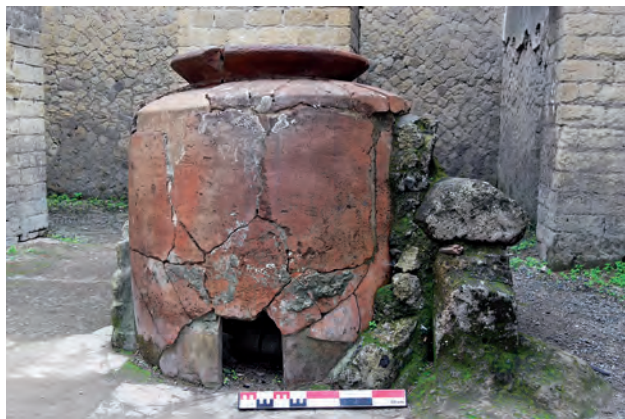
Fig. 93 – Dolium emmuré pour être utilisé comme fourneau dans l'atelier Or. II, 5. À droite, il s'appuie sur la table maçonnée préexistante, destinée au nettoyage des toisons, et la recouvre partiellement (cliché pris de l'ouest).
