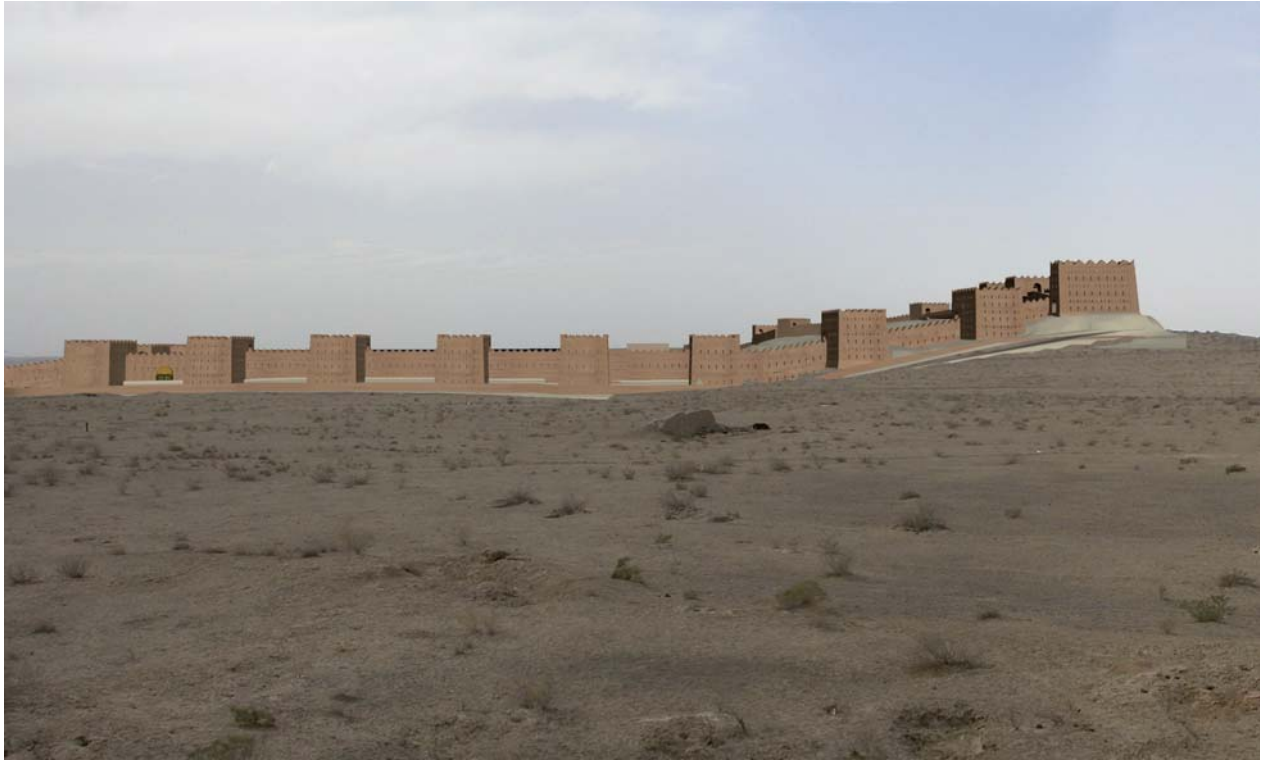
Fig .2. Vue vers l'ouest de la fortification de la colline du Chingiz Tepe.
