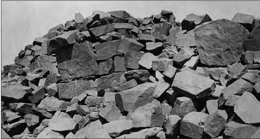
Fig. 2. Détail du monument. Photo prise par Félix Dubois en 1907, et conservée aux Archives départementales des Deux-Sèvres.
