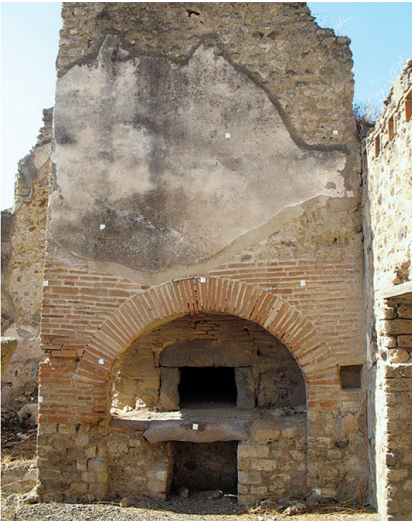
Fig. 74 - Pompéi, Pistrina . Vue générale du four en V 4, 01-02. En avant de la gueule du four et de l'autel se trouve le mur diaphragme, avec son arc caractéristique. Notez les changements d'appareil entre les zones inférieure et supérieure de la paroi (cliché A. Coutelas).
