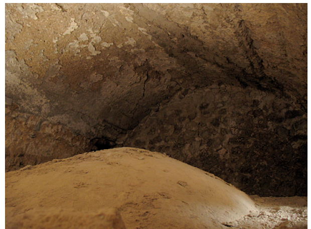
Fig. 73 - Pompéi, Pistrina . Vue de l'intérieur de la coupole du four en VII 2, 3.6-7. Notez le premier rang de blocs en trachyte (cliché A. Coutelas).
