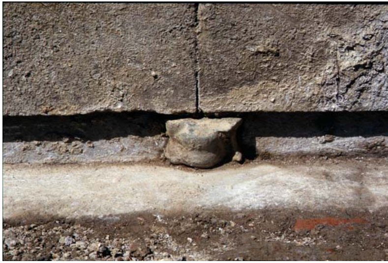
Figure 3 : Astragale de bronze scellé à la base d'un joint montant de la crépis (cliché J.-Ch. Moretti)
