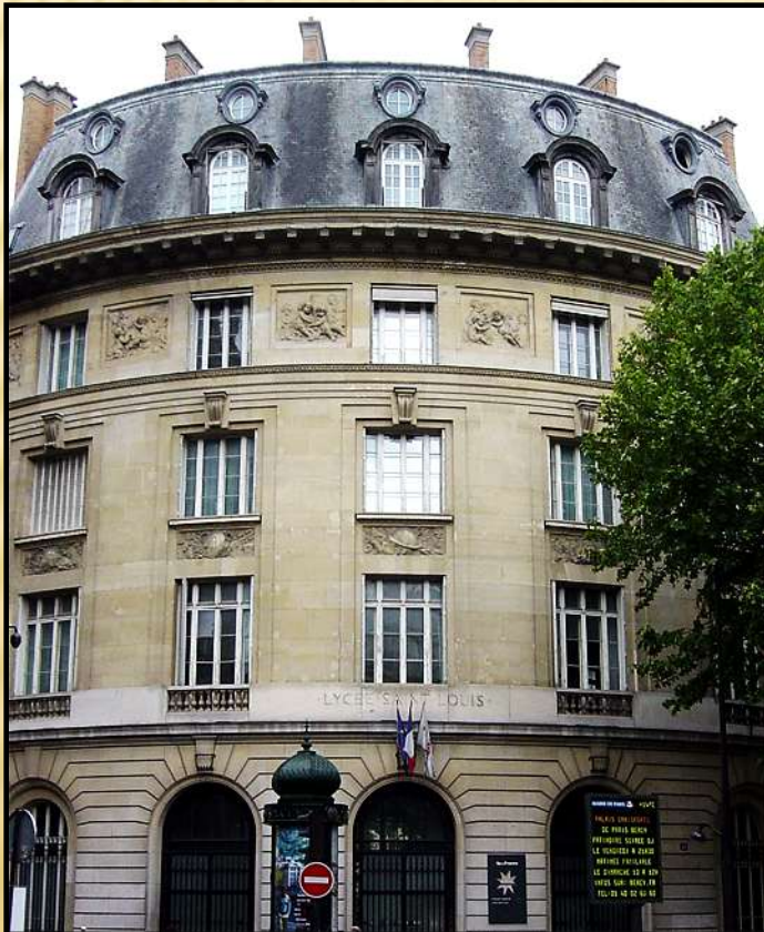
Entrée principale façade boulevard Saint-Michel
