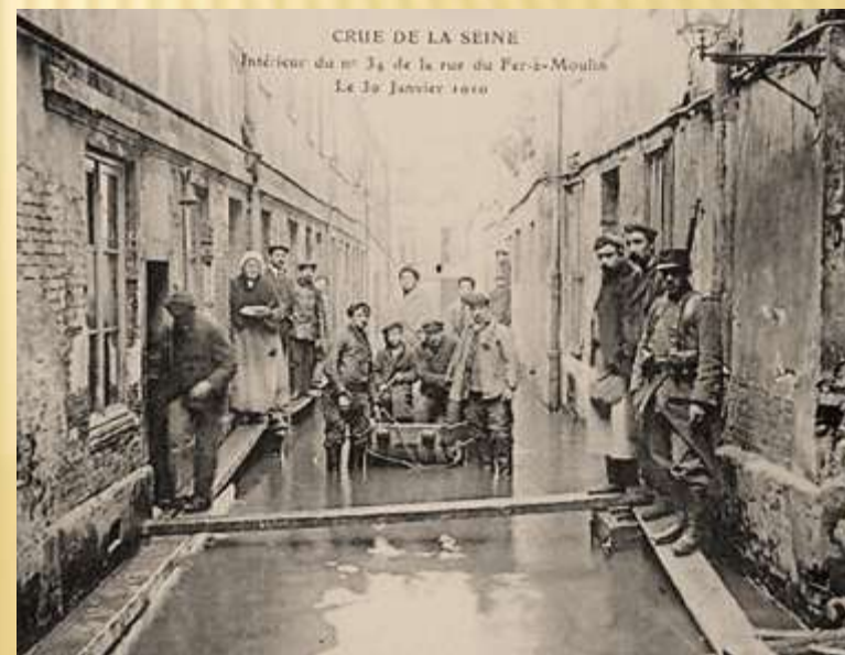
Inondation 1910. Rue du Fer à Moulin
