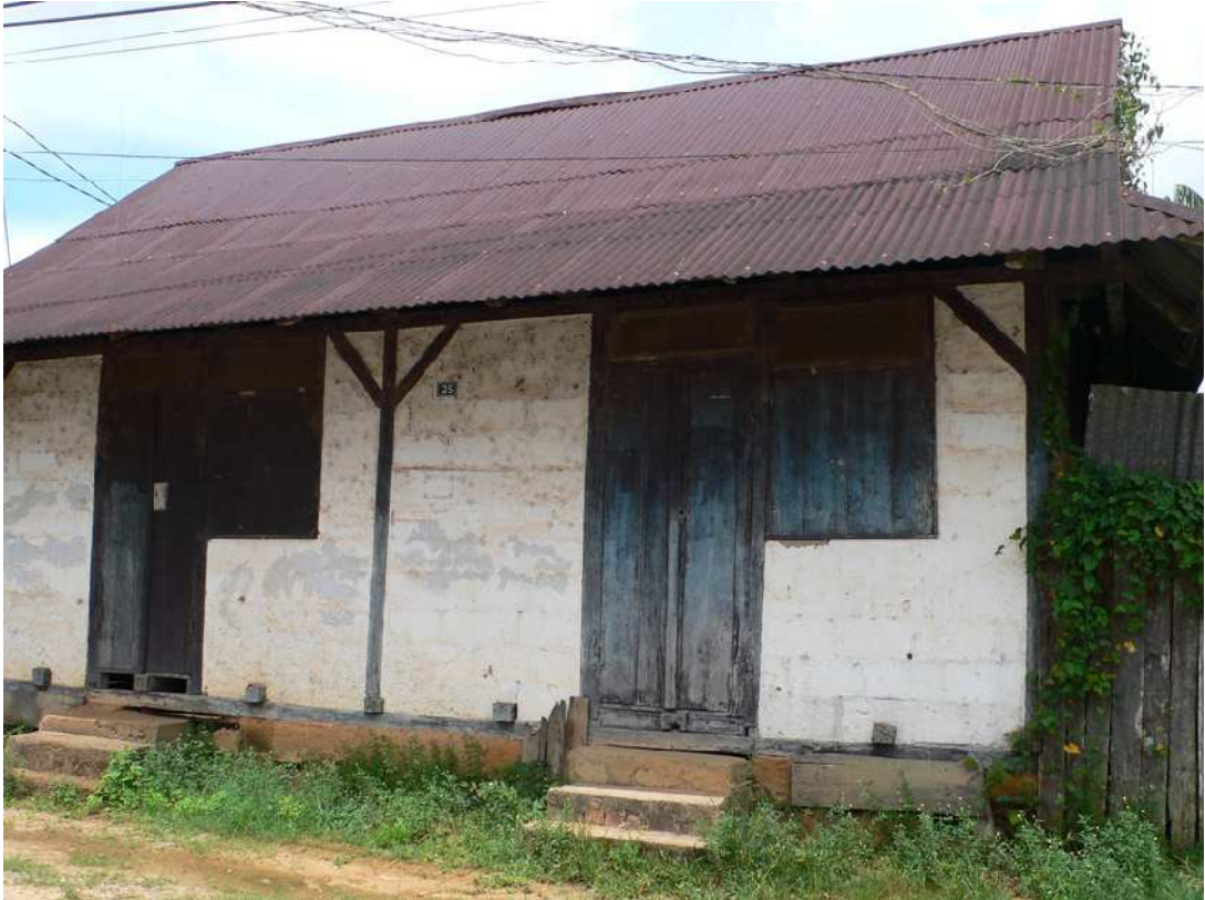
Deux exemples de petites cases en double compartiment (le type le plus ancien, antisymétrique, en haut) Les larges débords de toiture protègent efficacement les murs contre les pluies battantes
