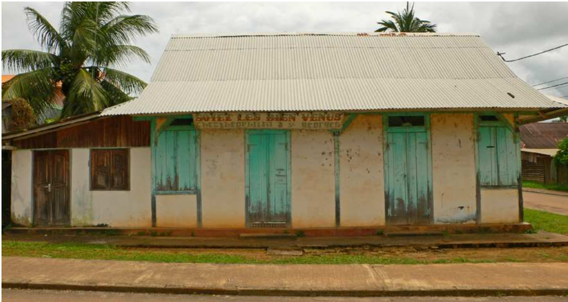
Deux exemples de petites cases en double compartiment (le type le plus ancien, antisymétrique, en haut) Les larges débords de toiture protègent efficacement les murs contre les pluies battantes
