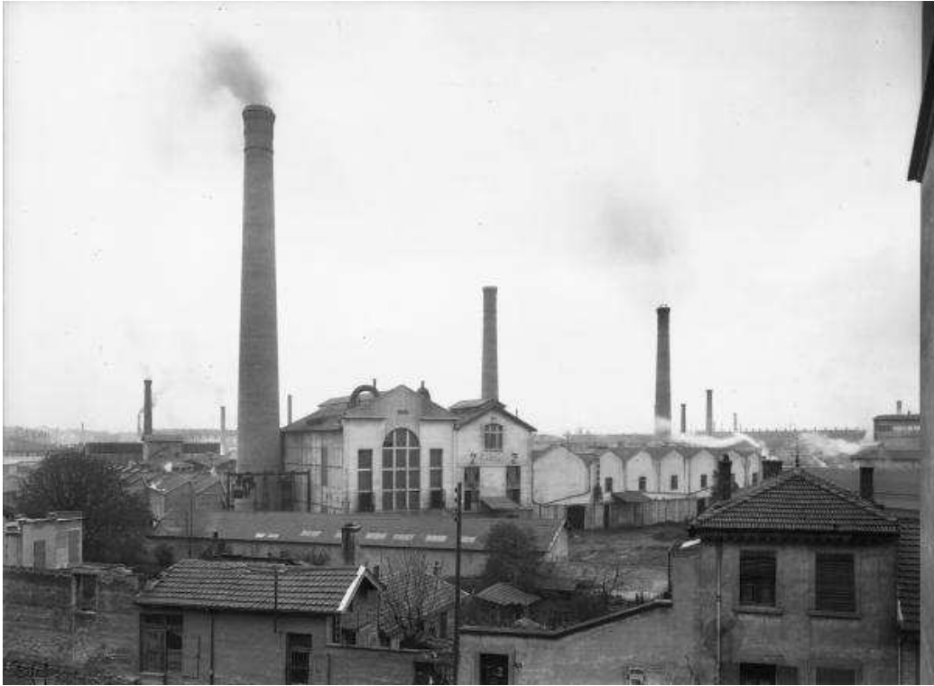
L'usine textile Gillet/SASE à Villeurbanne(1930)
