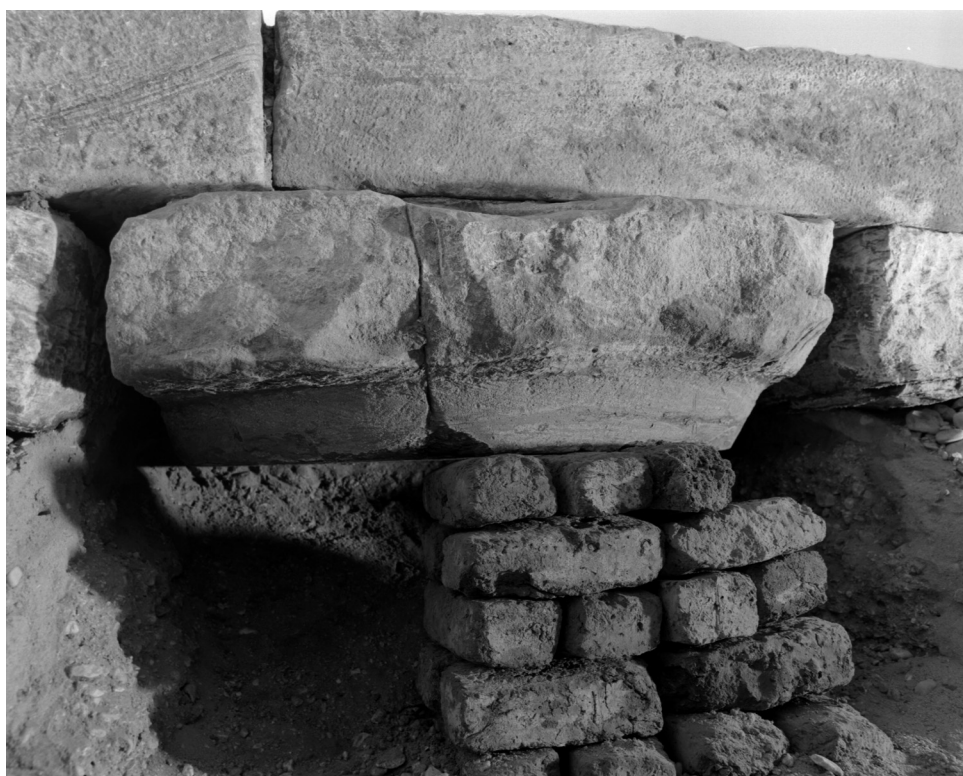
Fig. 12b. Base de colonne en grès rouge (n° 2) réemployée du côté nord. © Cnrs-Cfeetk/A. Chéné.
