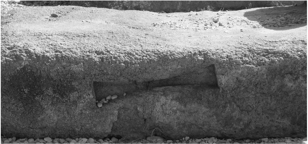
Fig. 24a. Queue d'aronde du troisième seuil de granit rose de la « cour du Moyen Empire » à Karnak.
