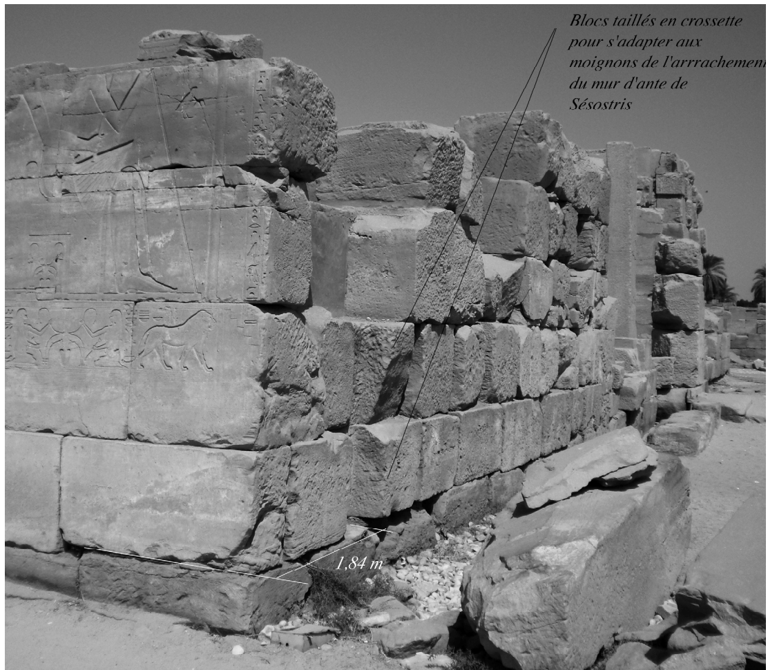
Fig. 33. Découpe à l'extrémité sud de la face orientale des salles sud d'Hatchepsout, ménagée afin d'épouser les moignons subsistants de l'arrachement du mur d'ante de Sésostris I er .
