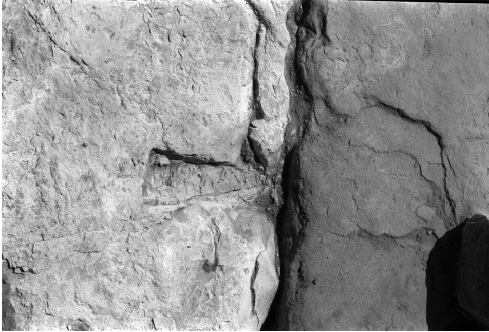
Fig. 8a. Bloc de remplissage en calcaire réutilisé dans la 2 e assise de fondation de la plate-forme, avec la queue d'aronde en surface. © Cnrs-Cfeetk/A. Chéné.
