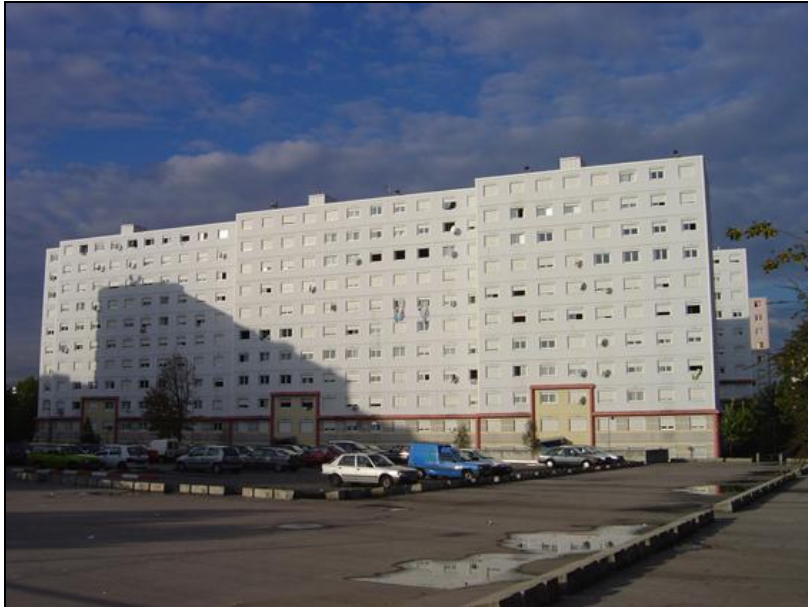
Figure 3 : Façade du 15 au 19 Chemin avant la réhabilitation
