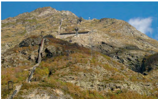
Conduite forcée et station de pompage à Pragnères
