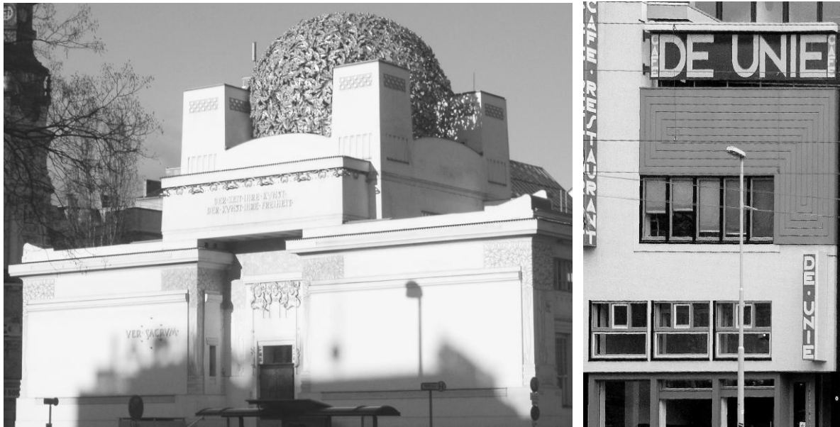
J.-M. Olbrich, immeuble de la Sécession, Vienne 1898, et J. J. P. Oud, café De Unie, Rotterdam 1924.
