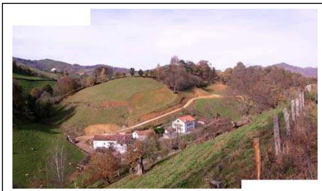
Photo 17 : extension de prairie, création d'un voie d'accès , édification d'un terre plein artificiel ...
