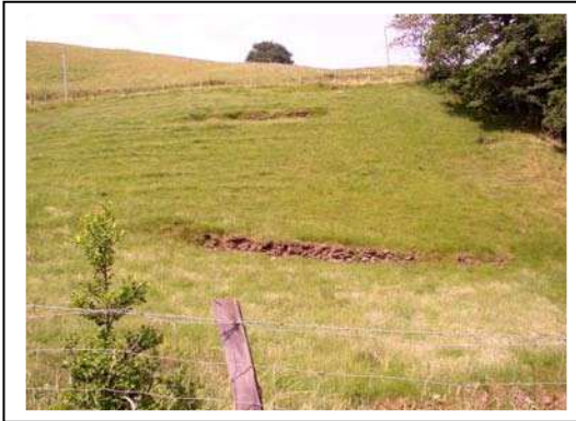
Photo 39 : stabilisation du sol par adjonction de murettes
