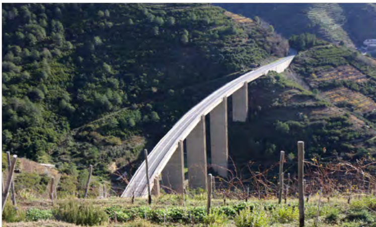
Le grand viaduc routier réalisé dans les années 1960 dont la destruction est programmée en 2010.
